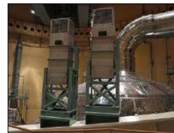
静的触媒式水素再結合装置
